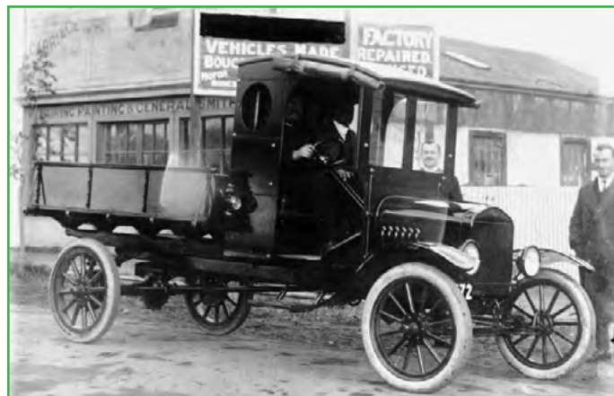
Ilustracja 2. Nawet lekkie ciężarówki, takie jak Ford TT, miały na tylnych osiach opony z pełnej gumy, ponieważ były trwalsze od opon pneumatycznych i umożliwiały transport cięższych ładunków. Źródło: domena publiczna
